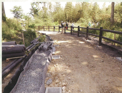
ふるさとゾーン園路設置中
