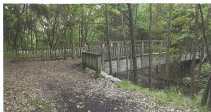
林間トレイルのような陸橋(下は森の小路)
