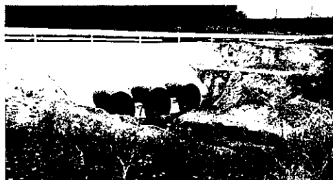
里の森ゾーン・ふれあいゾーン間の市道下にできた3本のコルゲート管と水路周辺
