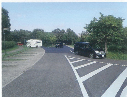
アスファルト舗装の完成
