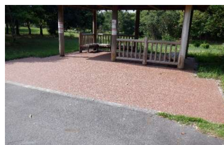
修繕後の四阿土間
